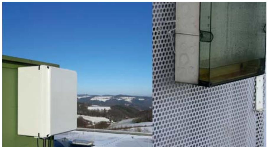
**Bild 1:** Extreme Witterung in Kombination mit hoher Schutzklasse kann zu Kondensat im Inneren führen – es drohen erhebliche Folgeschäden
