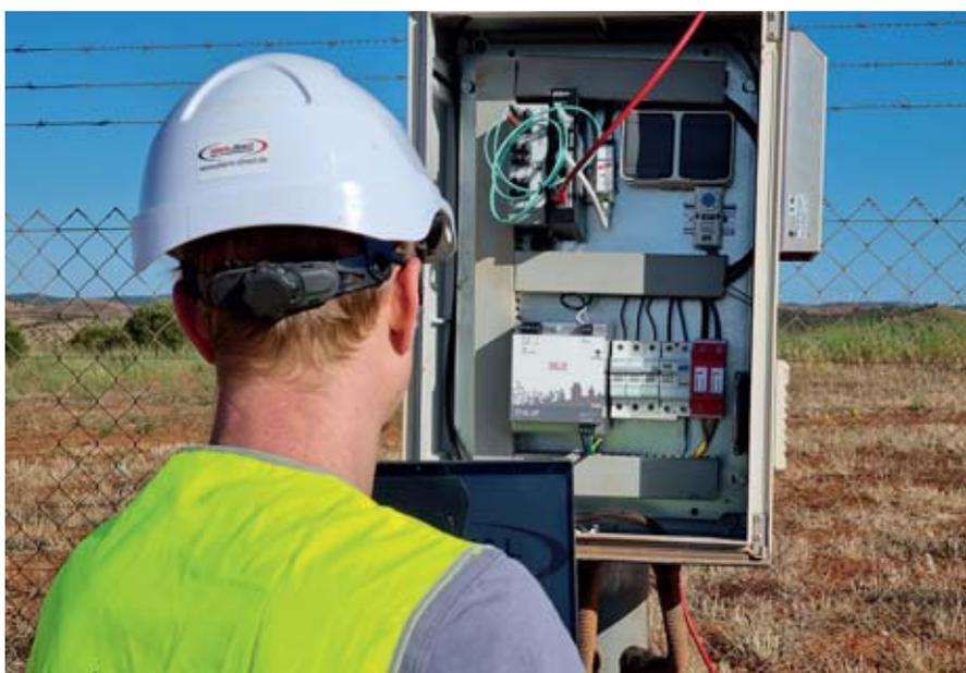
**Bild 3:** Die Mikro-USV vom Typ »SDC-M 48V DIN2 RS« von Slat sichert den Weiterbetrieb der angeschlossenen Geräte bei Netzausfällen und Mikrounterbrechungen und reduziert durch Daten-Fernauslesung die Wartungseinsätze vor Ort
