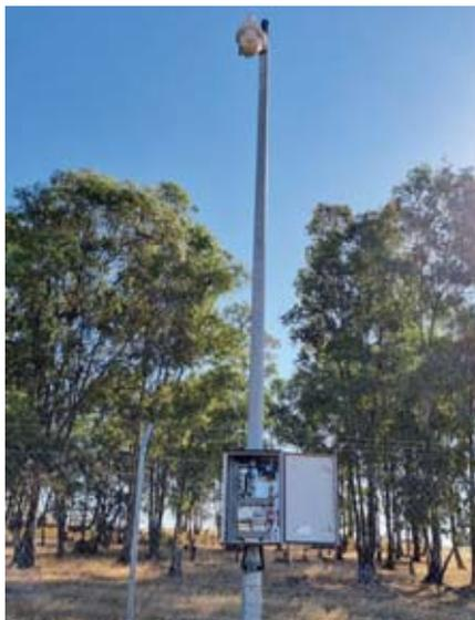
**Bild 2:** Eine DC-USV-gepufferte Videoüberwachung ermöglicht auch in entlegenen Gebieten eine zuverlässige Perimetersicherung rund um die Uhr
