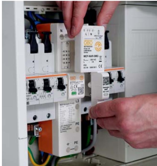
**Bild 1:** Ein Adapter für den Spannungsabgriff schafft Abhilfe bei beengten Verhältnissen
