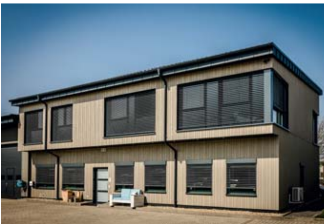
Bild 6: Das Firmengebäude wurde 2021 aufgestockt und bietet nun attraktive Räumlichkeiten für die Mitarbeiter
