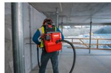
Bild: Akku-Bohrhammer im Einsatz mit dem Akku-Baustellensauger samt Rückenstragegurt.
