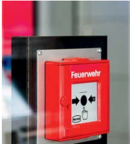
Bild 2: Die Peripherie für die örtliche Feuerwehr ist ein Kernelement jeder Brandmeldeanlage: angepasst an die Technischen Aufschaltbedingungen wählt der Planer alle relevanten Komponenten aus
