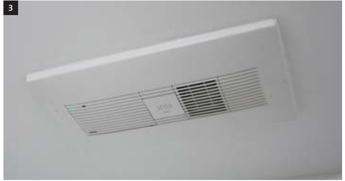
Bild 2: Für die zwölf barrierefreien Mikroapartments mit Badezimmer und Wohnbereich mussten durch den Einsatz der dezentralen Lüftung bei der Planung keine besonderen Brandschutzmaßnahmen berücksichtigt werden
