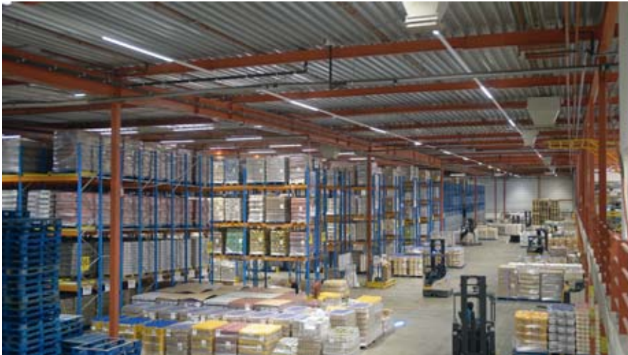
Bild 4: Das niederländische Logistikunternehmen Nedcargo nutzt die LED »E-Line Next« mit der besonders leistungsfähigen POF-Verkabelung für einen breitbandigen Datentransfer
