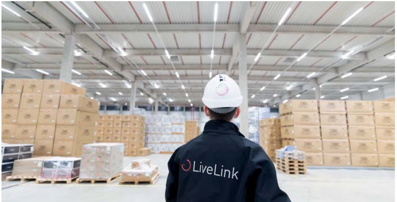
Bild 1: Im Logistikzentrum von Kühne + Nagel in Obergeorgswerder wurden IoT-Module in das LED-Lichtbandsystem »E-Line Next« eingebunden; sie analysieren die Lauf- und Fahrwege per Heat Mapping
