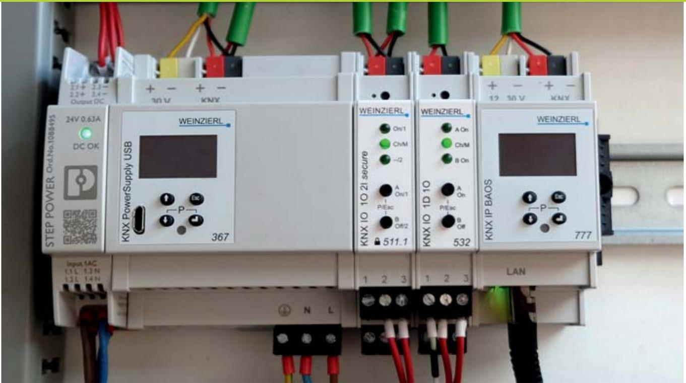
**Bild 1:** Erweiterter Testaufbau mit dem KNX-IP-Gateway »BAOS 777« von Weinzierl (rechts)
