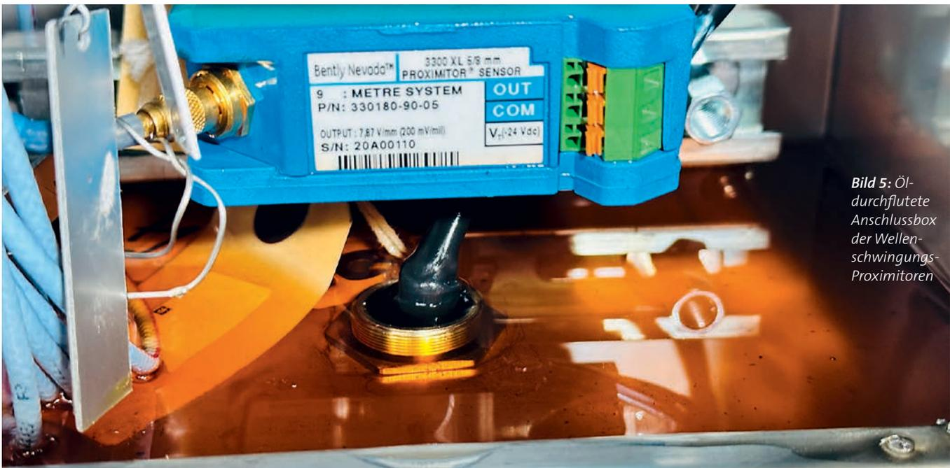
Bild 5: Öl-durchflutete Anschlussbox der Wellenschwingungs-Proximitoren
