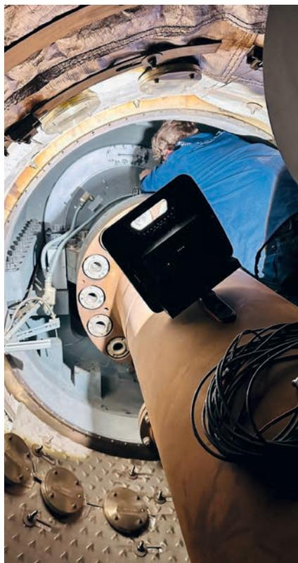
**Bild 2:** Demontage der Schwingungssensoren im »Wellentunnel« einer Gasturbine
