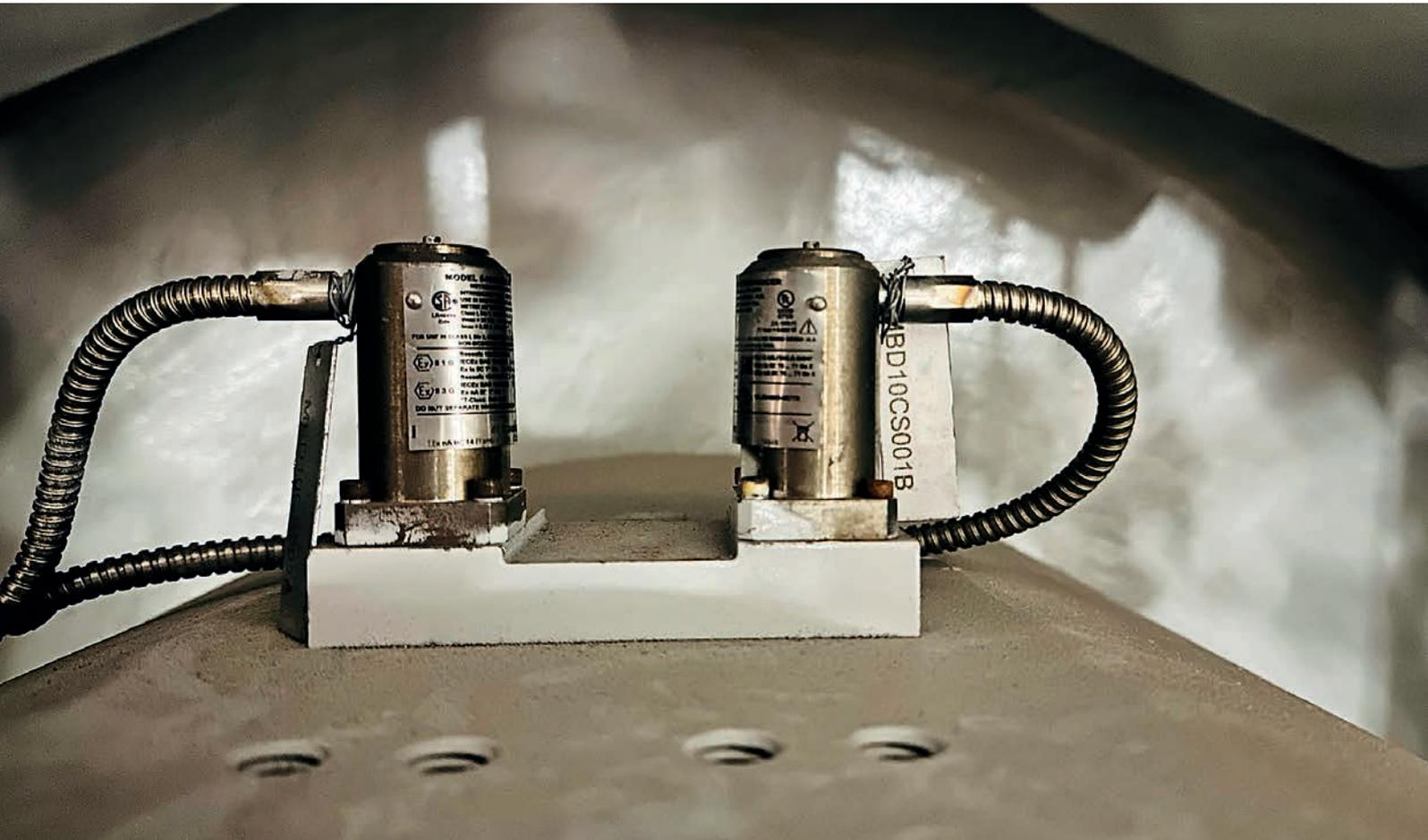
Bild 1: Zwei redundante seismische Hochtemperatur-Lagerschwingungssensoren an einer Gasturbine
