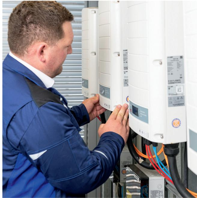
*Bild 2: TÜV-SÜD-Experte bei der Prüfung der ordnungsgemäßen Montage und des elektrischen Anschlusses der Wechselrichter*
