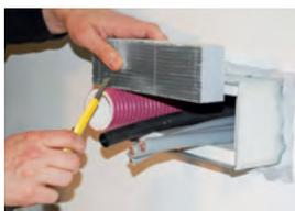
8. Nach der Kabelinstallation werden die EasyFoam – Stopfen einige mm größer als benötigt zugeschnitten, damit sie hinterher fest in der Öffnung sitzen.
