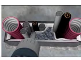
6. Danach werden alle Restöffnungen mit einem dauerelastischen Dichtstoff, wie z.B. Silikon oder Acryl, rauchdicht verschlossen.
