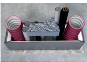
5. Der Stopfen wird mit der Restfolie nach außen in die Restöffnung eingesetzt. Reste können z.B. zur Abdichtung von Leerrohren genutzt werden.
