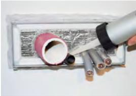
**10.** Danach werden alle Restöffnungen mit einem dauerelastischen Dichtstoff, wie z.B. Silikon, rauchdicht verschlossen.
