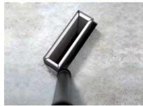
2. Die Kabelbox setzen Sie senkrecht so ein, dass der Spalt umlaufend von allen Seiten dicht mit Mörtel gefüllt werden kann und dass die Kabelbox auf keiner Seite mehr als 6 cm aus der Decke steht. Zum Einfüllen des Mörtels können Sie eine Kelle oder Mörtelpumpe verwenden.
