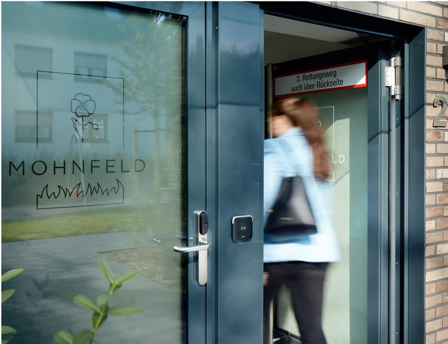
**Bild 2:** Wandleser an einer Haustür der Wohnungsgenossenschaft, links daneben sichert ein elektronischer »XS4 Original«-Beschlag den Fahrradabstellraum der Mieter
