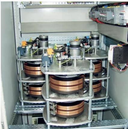
Bild 2: Meisterprüfungsprojekt – Stelltransformator als Prüfstand
