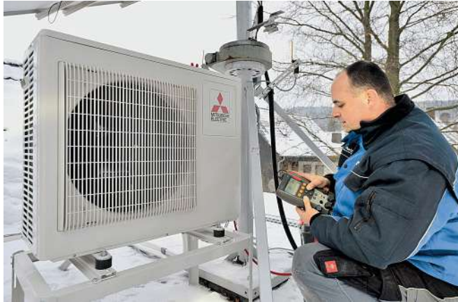
Bild 2: Split-Klimageräte sind prinzipiell wie Wärmepumpen aufgebaut. Deswegen können Klimageräte insbesondere in den Übergangszeiten die vorhandene Wärmeerzeugung entlasten oder auch komplett ersetzen
