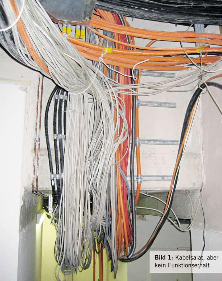
**Bild 1:** Kabelsalat, aber kein Funktionserhalt
