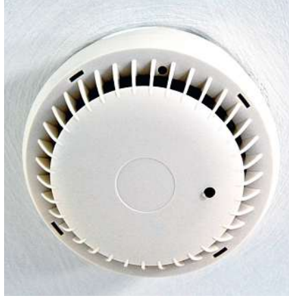
Bild 10: Die Rauchwarnmelder FRW können über den wibutler im Brandfall ein eigenes »Szenario« in Gang setzen: Rollläden hoch, Licht an, akustischer Alarm und Meldung auf das Smartphone
