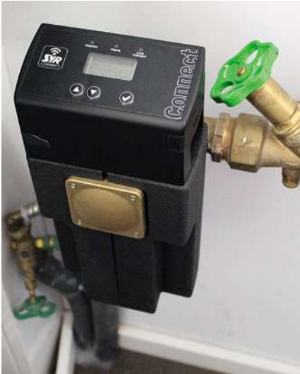
Bild 8: Die Überwachungseinheit SYR Safe-T Connect erkennt Leckagen, sperrt im Alarmfall die Hauptwasserleitung ab und sendet über wibutler eine Benachrichtigung auf das Smartphone des Nutzers
