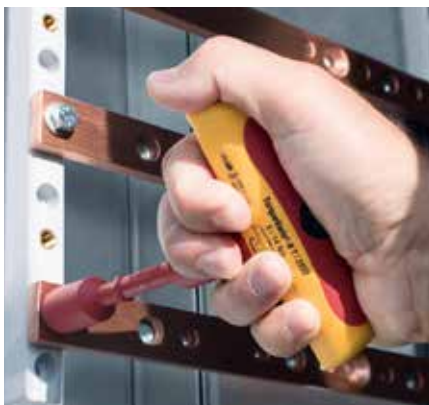
Bild 2: Drehmoment-Werkzeuge werden häufig bei Arbeiten des Elektrohandwerks eingesetzt
