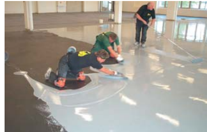
Bild 1: Aufbringen eines ableitfähigen Bodenbelags in fünf Arbeitsgängen beim Autozulieferer Hella in Recklinghausen
