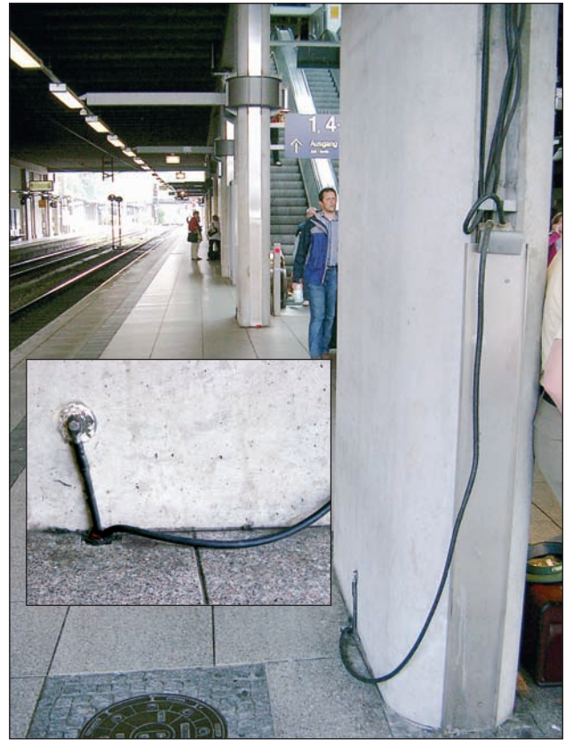
Bild 131: Fliegende, also ungeschützt verlegte Leitung auf dem Mainzer Hauptbahnhof
