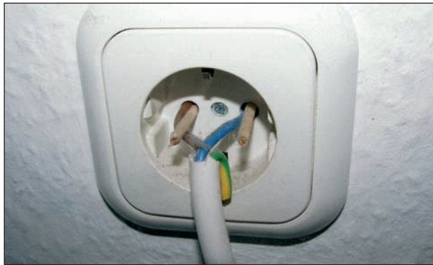
Bild 129: Mehr als abenteuerlicher Anschluss einer EDV-Anlage
