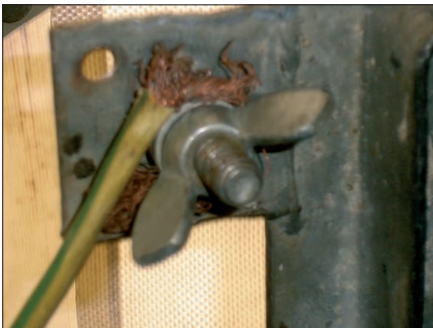
Bild 134: Unzureichende Befestigung des Schutzleiters an der Erdungsanschlusschraube
