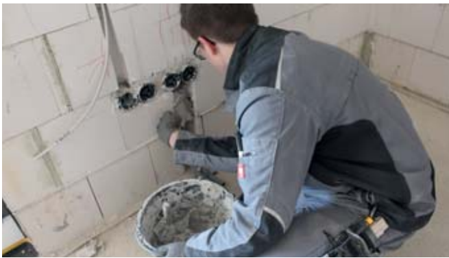
Bild 2: Auf eigenen Azubi-Baustellen lernen die Auszubildenden praxisnah und eigenverantwortlich
