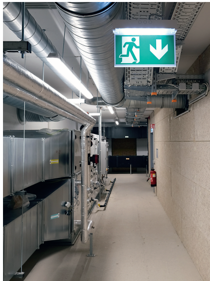
Bild: Modulare Rettungszeichenleuchte der KB-Serie in einem Versorgungsraum
