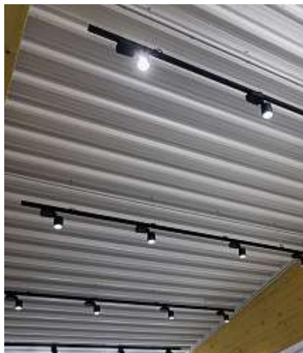
Bild 4: LED-Strahler an 3-Phasen-Stromschienen lenken dank visueller Kontraste die Blicke der Besucher auf definierte Verkaufsbereiche
