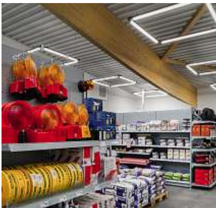
Bild 2: Für eine gleichmäßige flächige Grundbeleuchtung des Baustoffmarktes kommen Licht-Quadrate aus dem SDT-Schnellmontagesystem zum Einsatz
