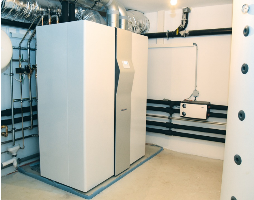
Bild 1: Ein Gerät für viele Funktionen: der Allrounder LWZ 504 übernimmt in jedem Gebäude die Ent- und Belüftung, Beheizung, Warmwasserbereitung und auf Wunsch auch Kühlung
