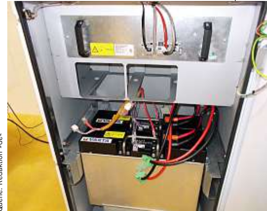
Bild 2: Innenansichten eines Speichers – hier der »Varta element«
