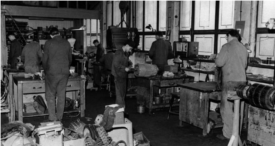
Bild 2: Ein Blick in die Motorenwerkstatt im Jahr 1960 – ca. 12 Jahre nach Gründung lag der Schwerpunkt der Arbeit in Reparatur und Neuwicklung elektrischer Antriebe
