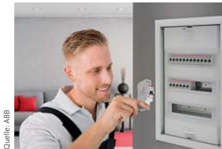
Bild 6: FI/LS-Kombination in einer Baubreite von 1 TE
