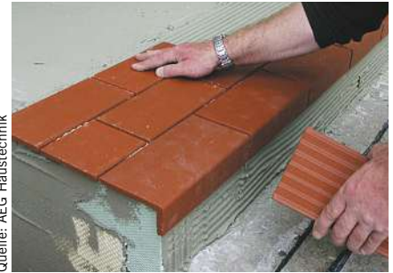
Bild 5: Bei Frostgefahr schaltet sich die Treppenheizung automatisch ein, so dass sich weder eine Schneeauflage noch eine Eisschicht bilden können
