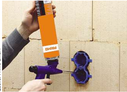
Bild 4: Die Kombination aus Thermdose und Thermoschaum liefert ein Ergebnis, das wärmebrückenfrei, schallgeschützt und winddicht ist. Außerdem lässt es sich schnell montieren
