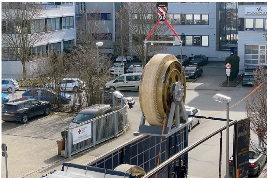
Bild 3: Verladen der fertigen Luftspulen mittels Kran und Tieflader
