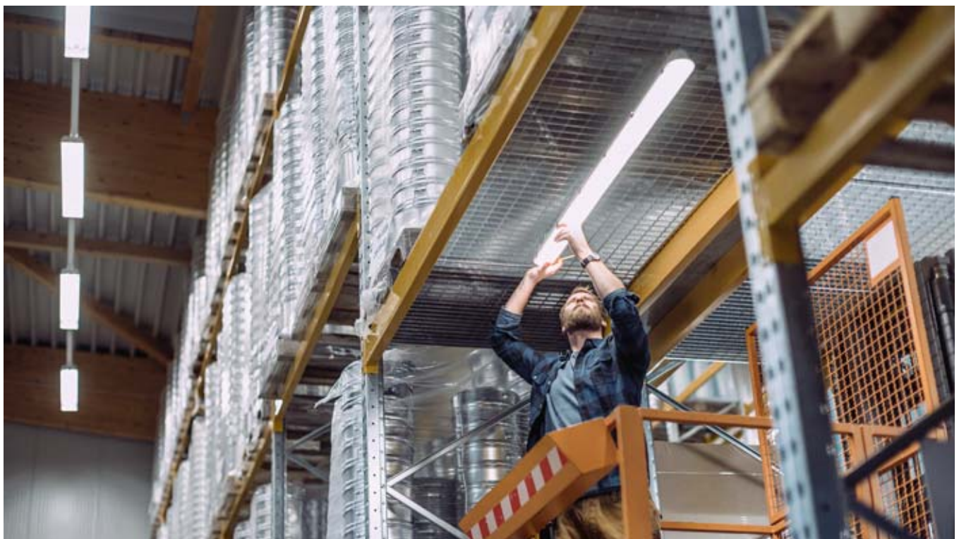
Bild 1: Die Umstellung von Leuchtstoffröhren und LED-Tubes bringt eine deutliche Reduzierung der Strom- und Wartungskosten
