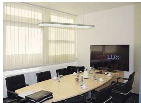
Bild 13: Gutes Licht umfasst bei EFG das Human Centric Lighting (HCL) und fördert beispielsweise bei Besprechungen die Kreativität. Die tageslichtabhängige Steuerung mit manueller Eingriffsmöglichkeit überzeugt nicht nur die eigenen Mitarbeiter sondern auch Besucher und Kunden gleichermaßen
