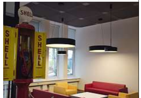
Bild 7: Die Pendelleuchten im Loungebereich (Studio Line von Bega) sind Dali-steuerbar und haben eine Farbtemperatur 3000 K
