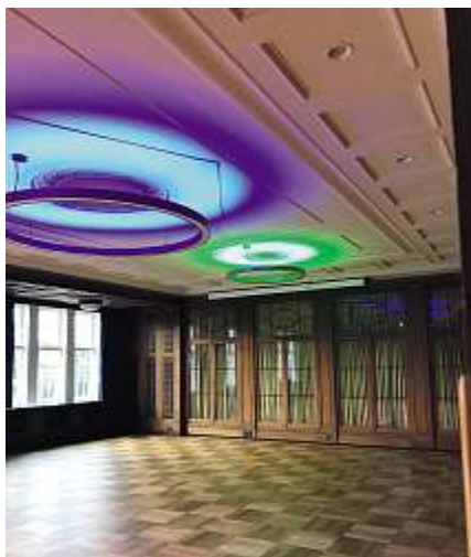
Bild 14: In einem denkmalgeschützten Gebäude sanierte Elektrohamburg AS die Beleuchtung und integrierte diese via DMX-Schnittstelle in die Gebäudesteuerung
