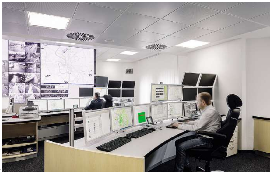
Bild 6: Gerade an Arbeitsplätzen ohne Bezug zum Außenraum wie in Leitwarten verbessert sich die Konzentrationsfähigkeit durch die Tageslichtsimulation; dafür ist die Einbauleuchte »Belvico« mit warmweißen und kaltweißen LEDs bestückt
