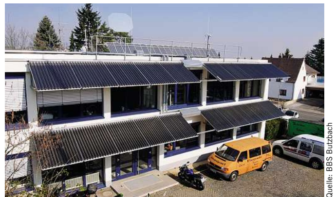
Bild 2: Solarthermische Anlage für den Antrieb einer Absorptionskältemaschine an der beruflichen Schule in Butzbach
