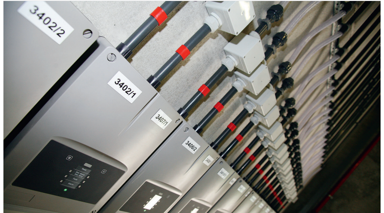
Bild 2: Je nach Größe des Hochregallagers werden mehrere Ansaugrauchmelder benötigt, um das gesamte Raumvolumen abzusichern
