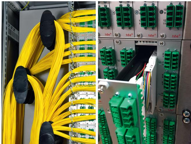
**Bild 2:** Mit Hilfe von Optical Distribution Frames (ODF) lassen sich große Faserzahlen strukturiert und dauerhaft übersichtlich auf geringem Raum terminieren
