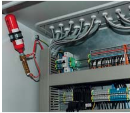
Bild 4: Das Kleinlöschsystem »Preveenos« mit Signalweiterleitung
