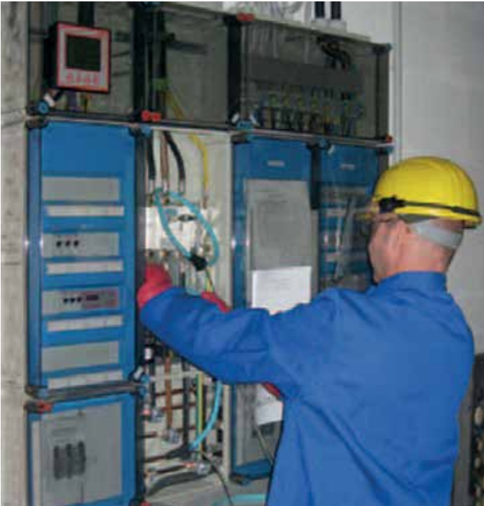
Bild 7: Einbau eines Netzanalysators in eine Verteilung
