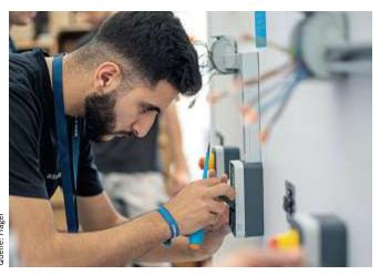
Bild: Installation einer Wechselschaltung mit Berker Q.7 und Berker W.1
